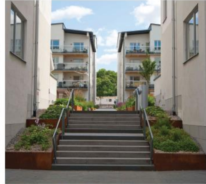
Öppningar mot bostadsgårdarna kantade med vegetation ger ett luftigt intryck från gatan och skapar en tydlig avgränsning mellan offentlig och privat mark.
